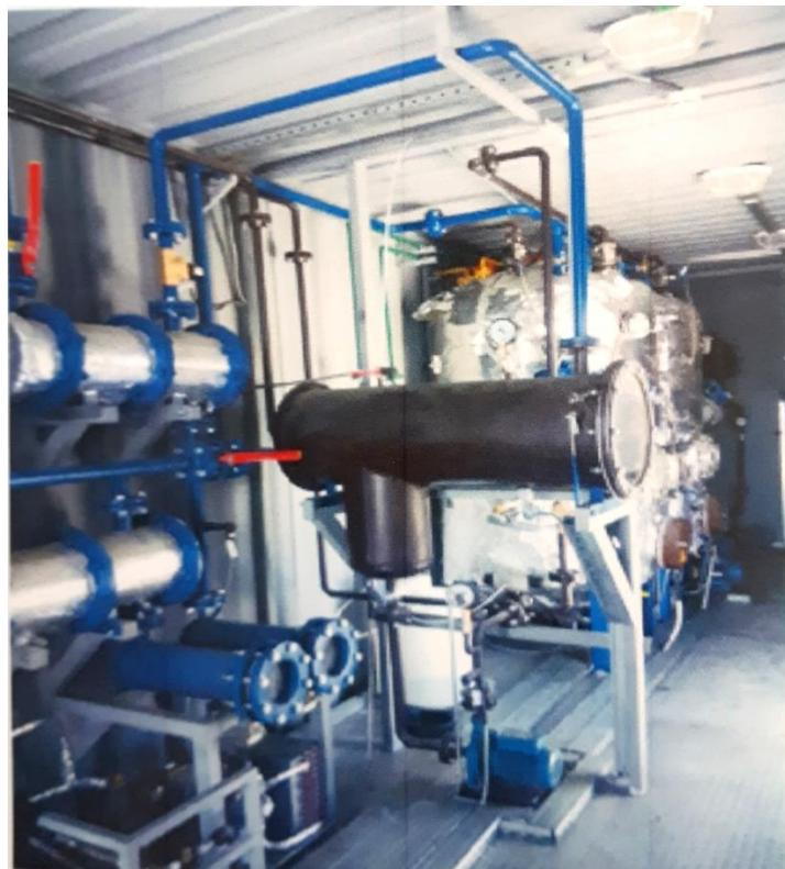
Рис. 3. Установка по очистке загрязненных трансформаторных масел.
